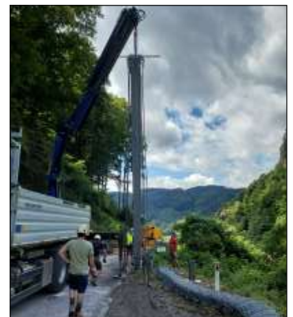
Die Steher des Schutznetzes hatten eine Höhe von 8,5 Meter.
