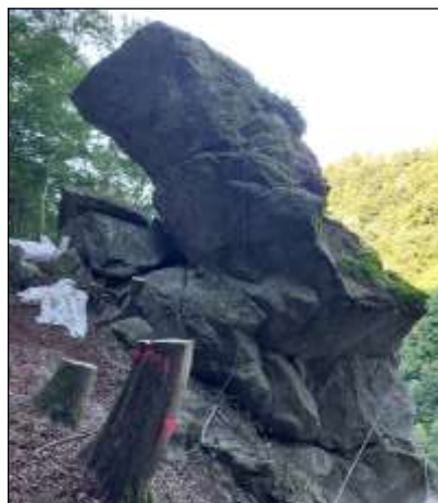
Der obere Teil des Felsblockes wurde gesprengt.
