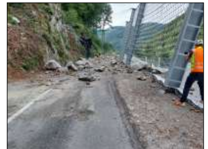
4 Fuhren Material wurden mit einem Vierachser-LKW nach der Sprengung abtransportiert.
