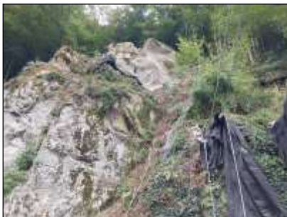
Der Felsblock von unten nach der erfolgreichen Sprengung.
