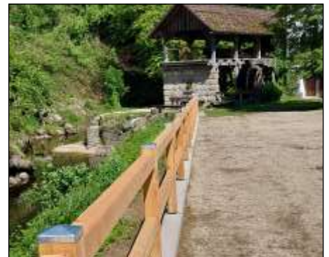
Blick auf das fertige, neue Geländer
