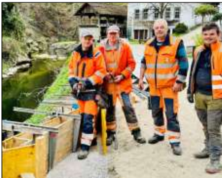
die Mitarbeiter der Straßenmeisterei Grein, v.l. Helmut Blauensteiner, Anton Mittermaier, Polier Manfred Kaiselgruber und Felix Koglgruber bei Schalungsarbeiten
