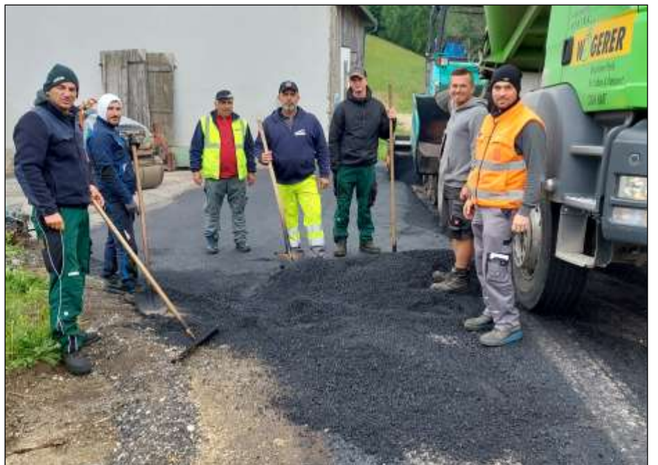
die Mitarbeiter der Firma Malaschofsky und WEV-Mitarbeiter Thomas Spiegl (r.) am Beginn der Asphaltierungsarbeiten der Zufahrt Achleitner—Familie Rumetshofer
